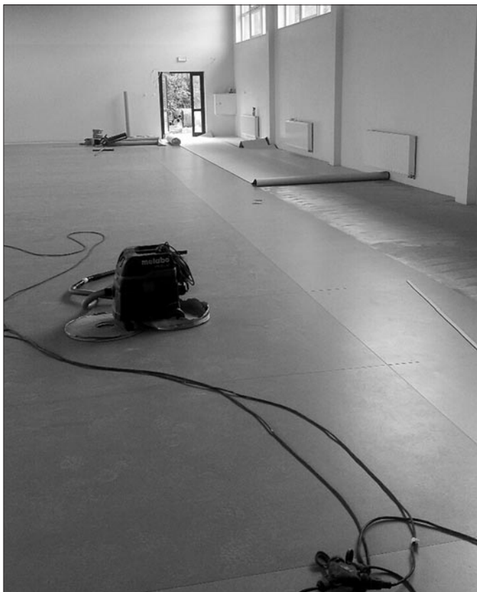
Prace wykończeniowe w sali gimnastycznej w Mszanie Górnej
