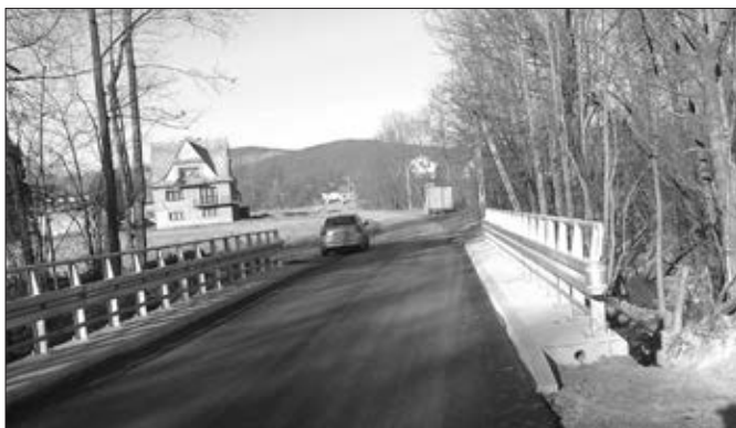
Most w ciągu drogi Kasina Wielka – Gruszowiec na osiedlu SZELIGI
