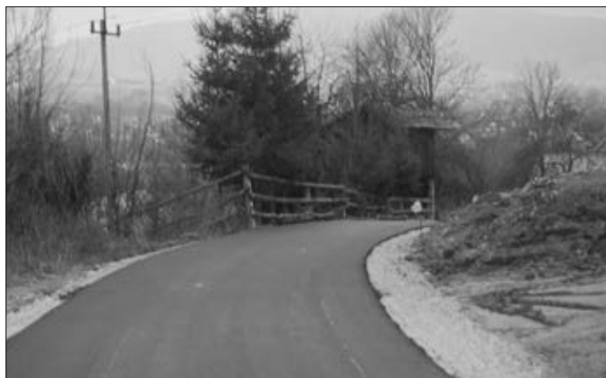
Droga na osiedlu STACHURY
