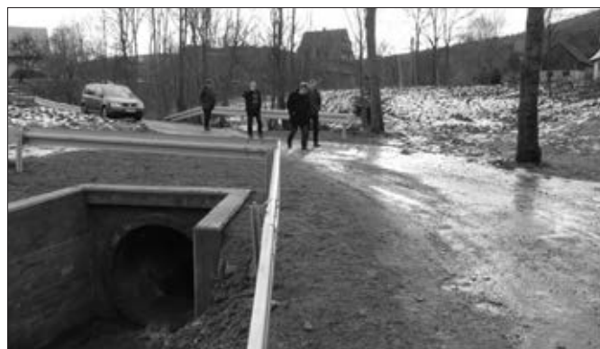
Przepust na osiedlu ŁACNE
