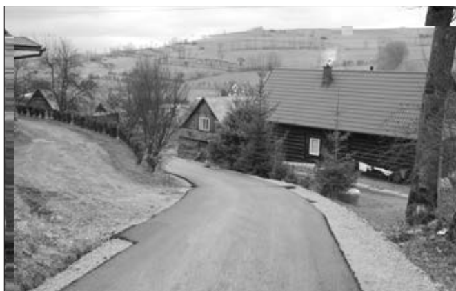
Droga na osiedlu SZCZEPANIAKI
