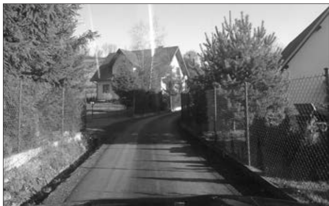
Droga na osiedlu ZAGRODY
