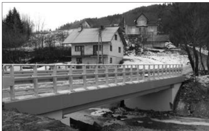
Most na osiedlu GOBORY
