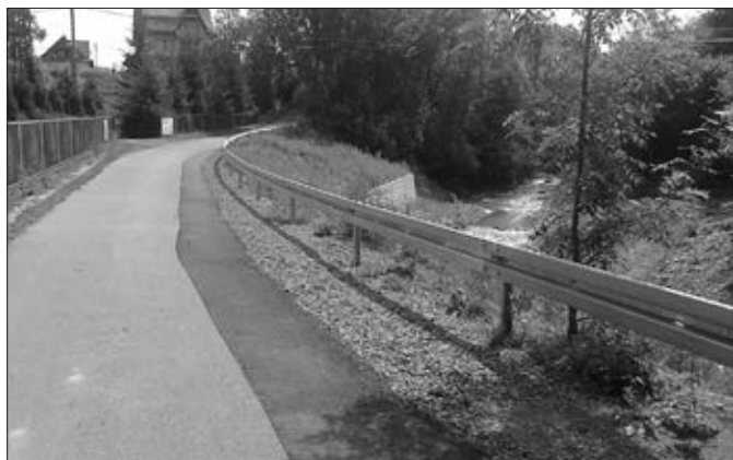
Droga na osiedlu KOPYTKI
