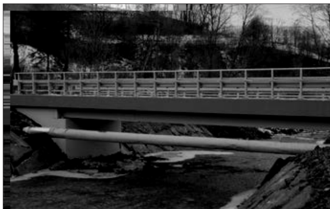
Most na osiedlu GOBORY
