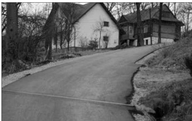
Droga na osiedlu SZCZEPANIAKI
