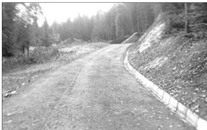
Droga na osiedlu PROŚKI – po realizacji
