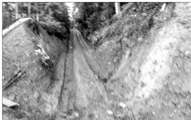
PROŚKI – przed realizacją
