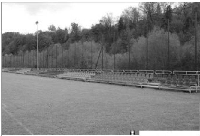
Ogrodzenie boiska oraz wykonanie minitrybun przy boisku „ZENIT” w Kasince Małej
