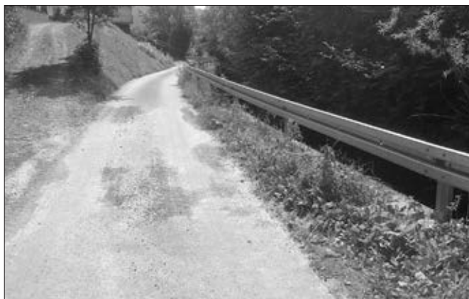
Droga do Przysiółka NOWA WIEŚ
