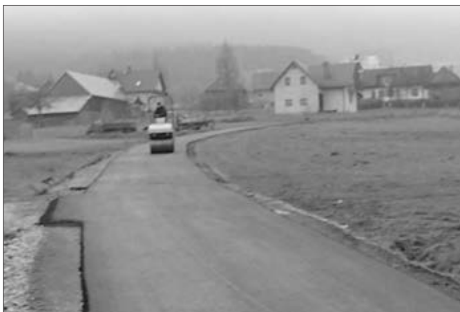
Droga do osiedla ŻĄDŁÓWKA
