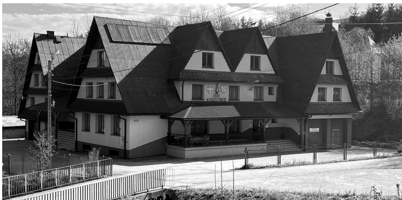
Budynek remizy OSP w Olszówce
